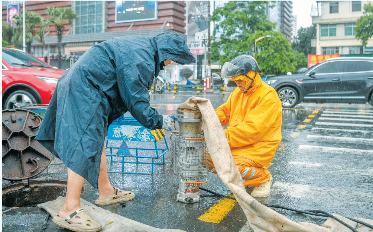
6月26日,海口持续降雨致使部分路段出现积水。在金龙路与龙华西路路口,排水工作人员使用水泵对积水点进行强排。 本报记者 孙士杰 摄
