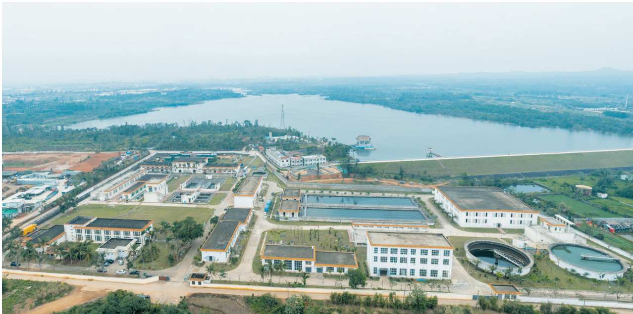
俯瞰海口永庄水厂。据悉,该水厂采用“臭氧+活性炭”深度处理工艺提升自来水品质。
