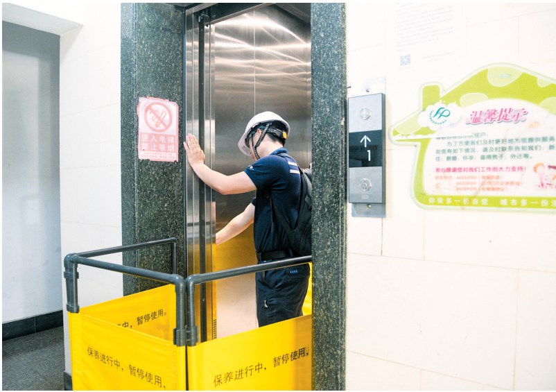
6月25日,在海口市美兰区金椰都滨海花园小区,工作人员正在对电梯进行维护保养。 本报记者 杨鹤 摄
