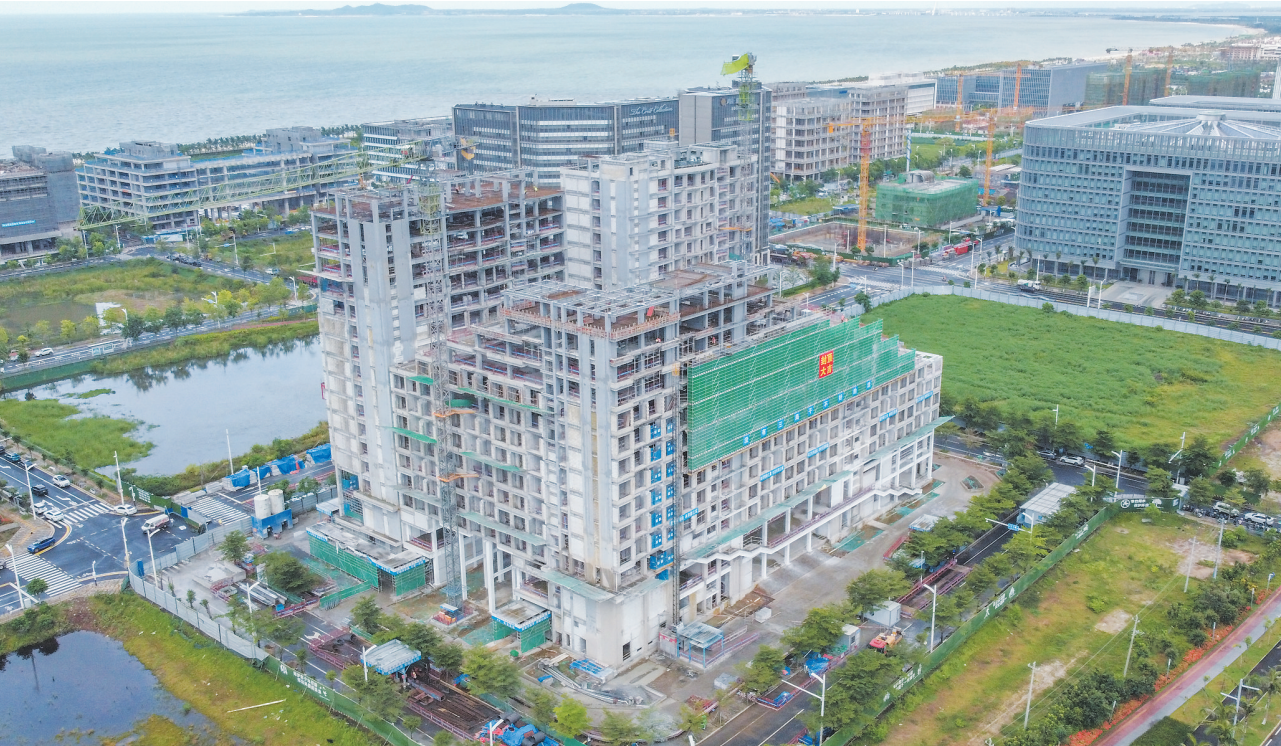
俯瞰位于江东新区总部经济区(生态CBD)的江东智慧国际公寓A区项目,一派繁忙的施工景象。 本报记者 孙士杰 摄
