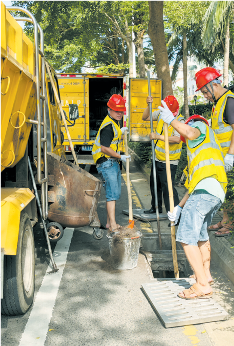
7月10日，在海甸六东路上，海口市排水设施事务中心的工作人员打开排水井清理淤泥。
