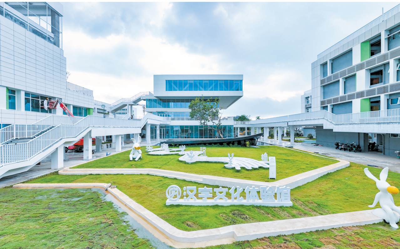
7月12日,在海南中学江东校区项目,综合楼、初中部教学楼等已完工,并完成室内教学设备安装。目前正在进行操场和校门的施工。
