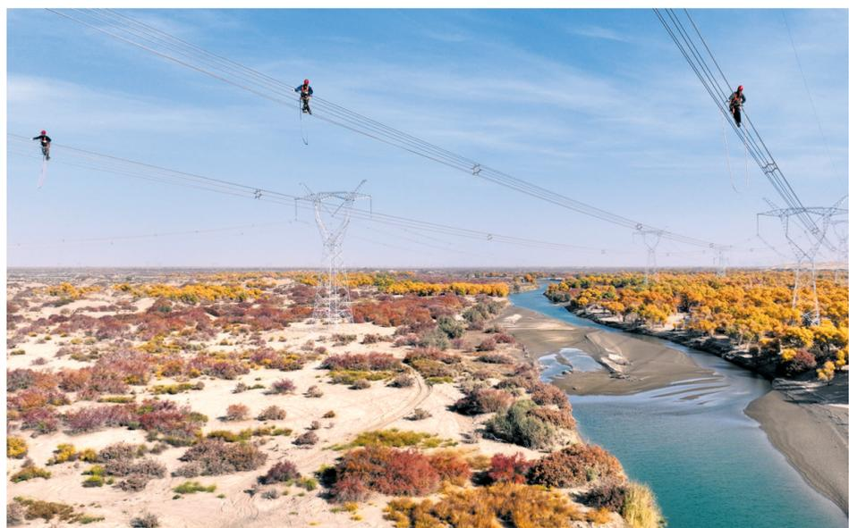
▲在巴州-铁干里克-若羌750千伏输电工程现场,作业人员开展走线消缺作业(2024年10月16日摄,无人机照片)。
