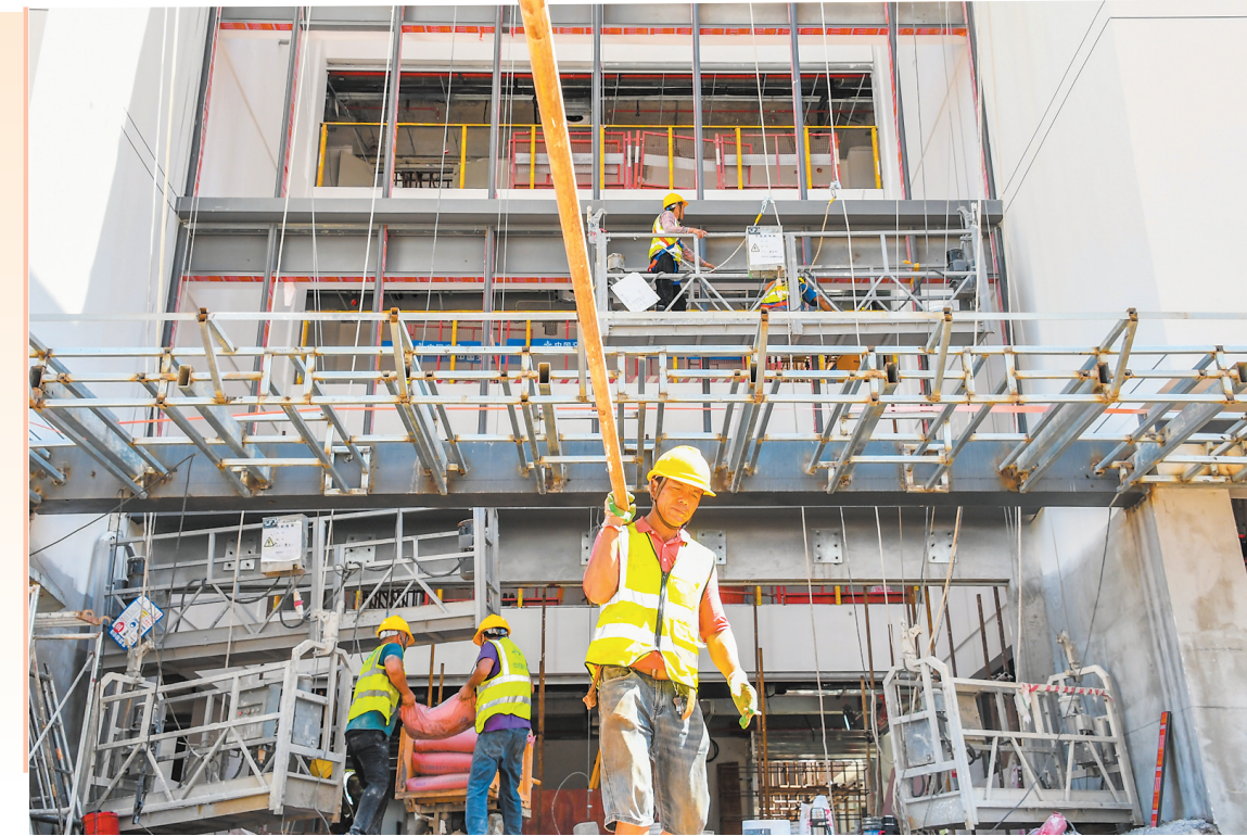
近日,新埠街道社区卫生服务中心已完成主体结构施工,工人正进行内部及外立面精装修。
