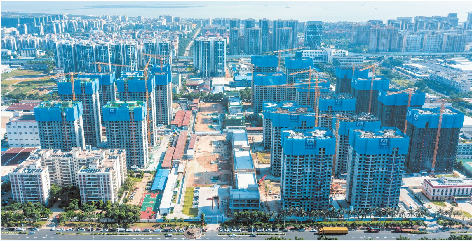
7月17日,鸟瞰海口浩业物流园安居房项目。 本报记者 石中华 摄
