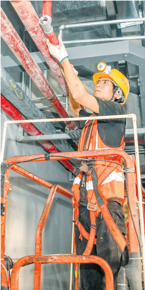
7月14日,在位于海口江东新区的国家紧急医学救援基地(海南)项目现场,施工人员正在安装机电设备。
