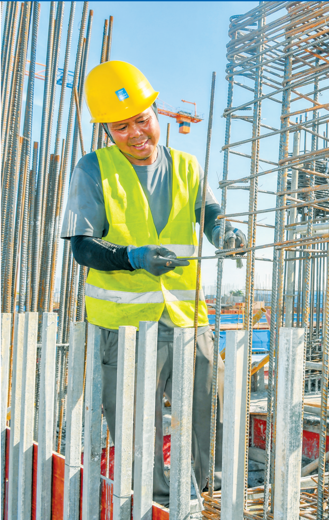
7月17日,在兰香园D04、D06地块项目现场,施工人员正在绑扎钢筋。
