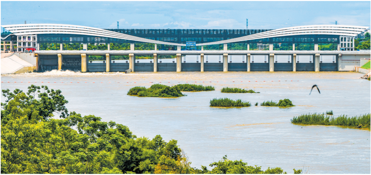
南渡江龙塘大坝“腾飞之翼”造型大气磅礴。 本报记者 康登淋 摄
