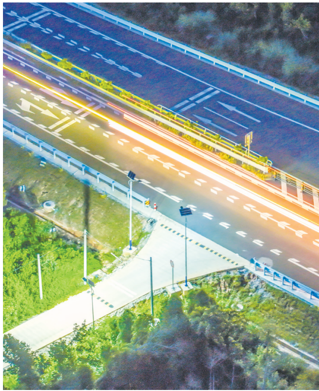
7月22日，夜幕降临，在羊山大道至母瑞山公路(遵谭段)，群力村路口处灯火通明，照亮了群众出行之路。 本报记者 康容淋 摄
