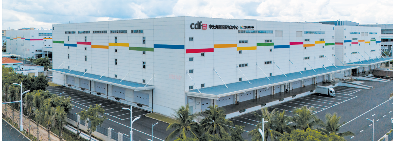
7月24日，航拍位于海口综合保税区的中海海南国际物流中心。
