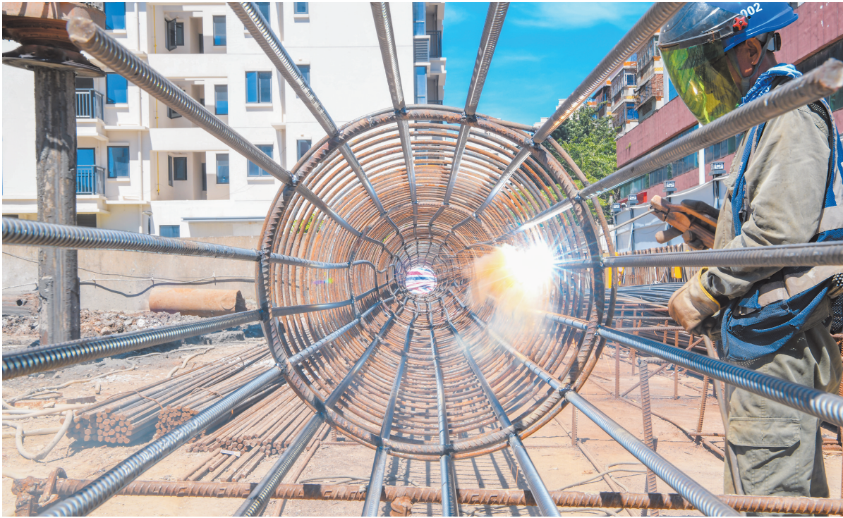
7月28日,在滨海立交桥东南侧景玉路上,排涝泵站正在建设中。 本报记者 苏锦坤 摄
