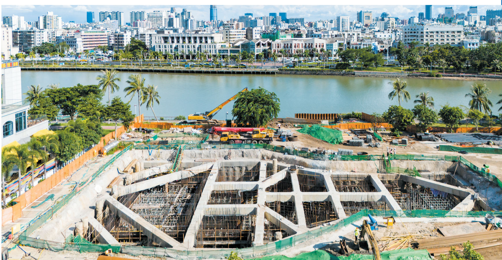
7月28日,在海甸溪雨水泵站项目现场,施工人员正在有序开展作业。 本报记者 苏弼坤 摄
