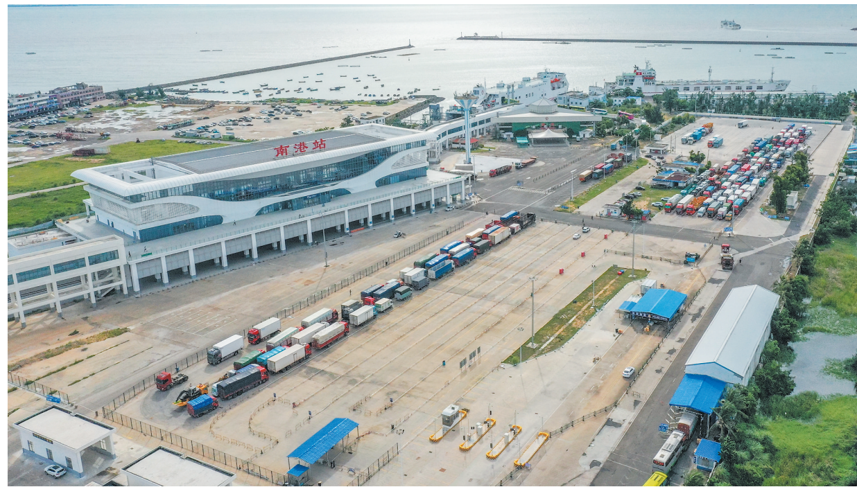
在财政资金保障下,今年5月,新建成的海口南港客运站正式通航启用。
