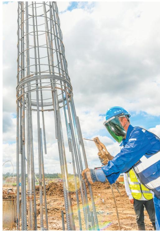
新海陆岛物流园区起步区工程项目(A包)现场施工人员在焊接钢筋笼。 本报记者 康登林 摄
