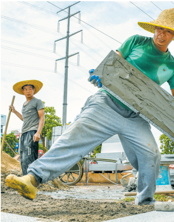
►8月5日,在海燕小学新校区门前的海风园(燕鸣园)建设现场,施工人员正在铺设地砖。
