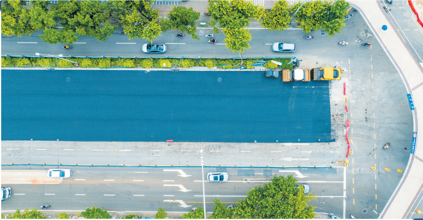
8月7日,海甸岛排水管网更新改造工程项目现场,海甸一西路至二西路路段已完成管网安装和沥青铺设。本报记者 杨鹤 摄
