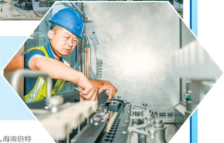
▲8月8日，在海南倍特药业仿创药物生产及研发基地一期项目，施工人员正在调试药品生产设备。 本报记者 孙士杰 摄
