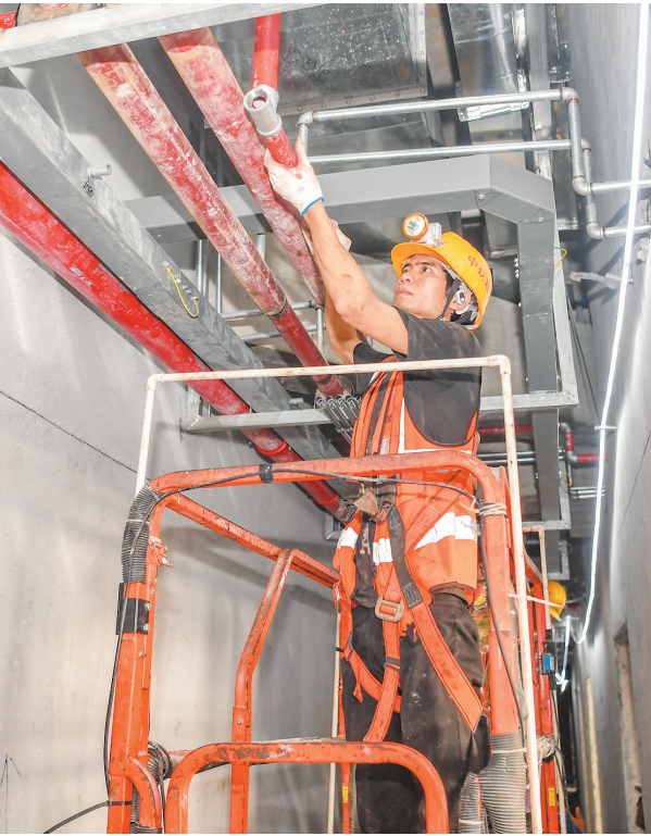
在位于海口江东新区的国家紧急医学救援基地(海南)项目现场,施工人员进行机电安装。 本报记者 孙士杰 摄
