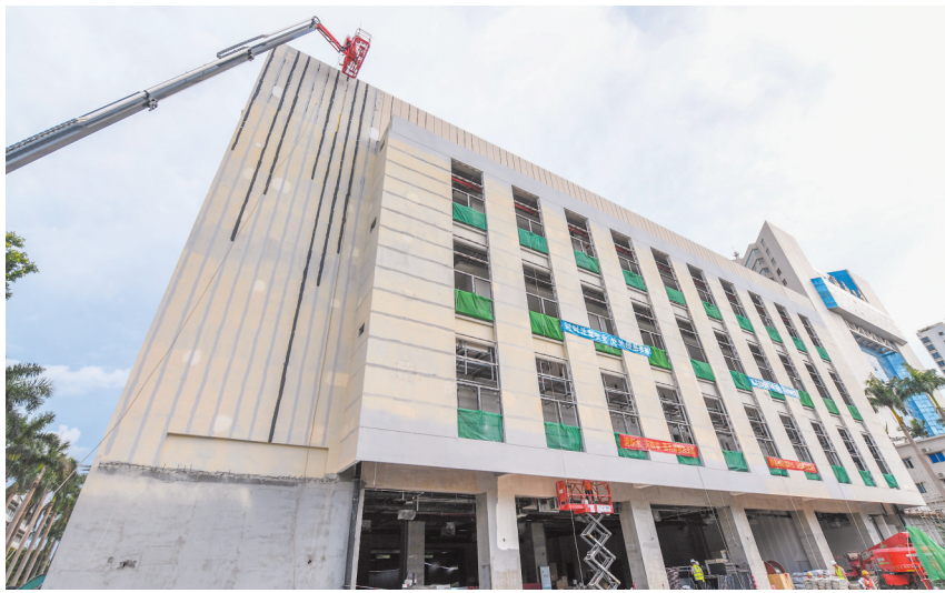
8月13日,中国联通海南海口国际信息港项目建设现场,施工人员正在进行外立面施工作业。 本报记者 康登林 摄
