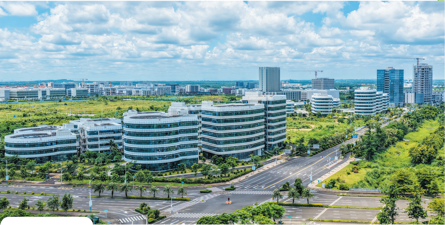
从空中俯瞰楼宇林立的海口国家高新区美安生态科技新城。 本报记者 康登淋 摄
