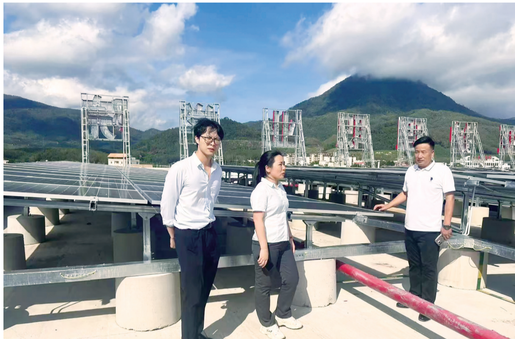
保亭的光伏项目,连片的光伏板持续产出清洁电力。
