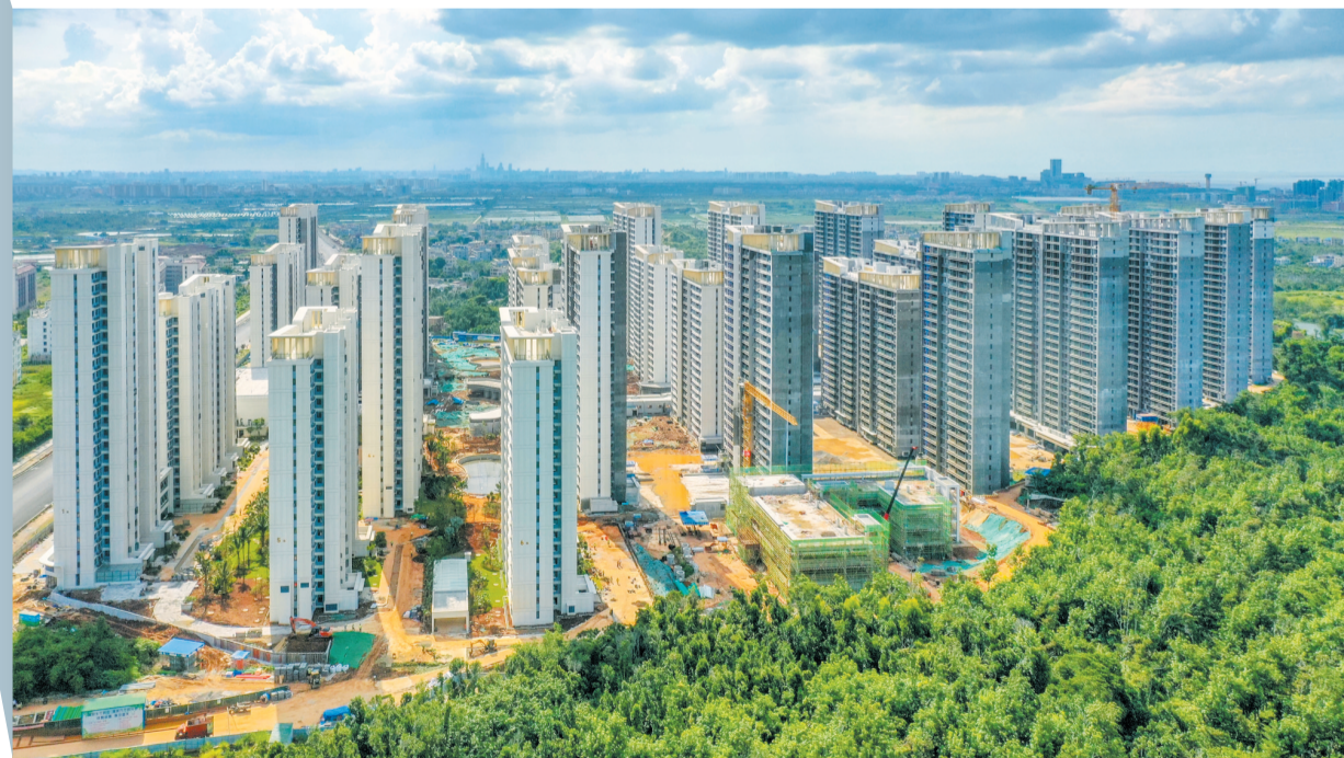
远眺江东·梧桐里项目,楼栋林立。本报记者 孙士杰 摄
