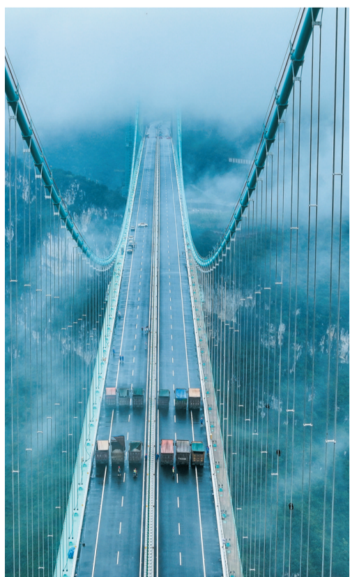
8月21日拍摄的贵州花江峡谷大桥荷载试验现场(无人机照片)。
