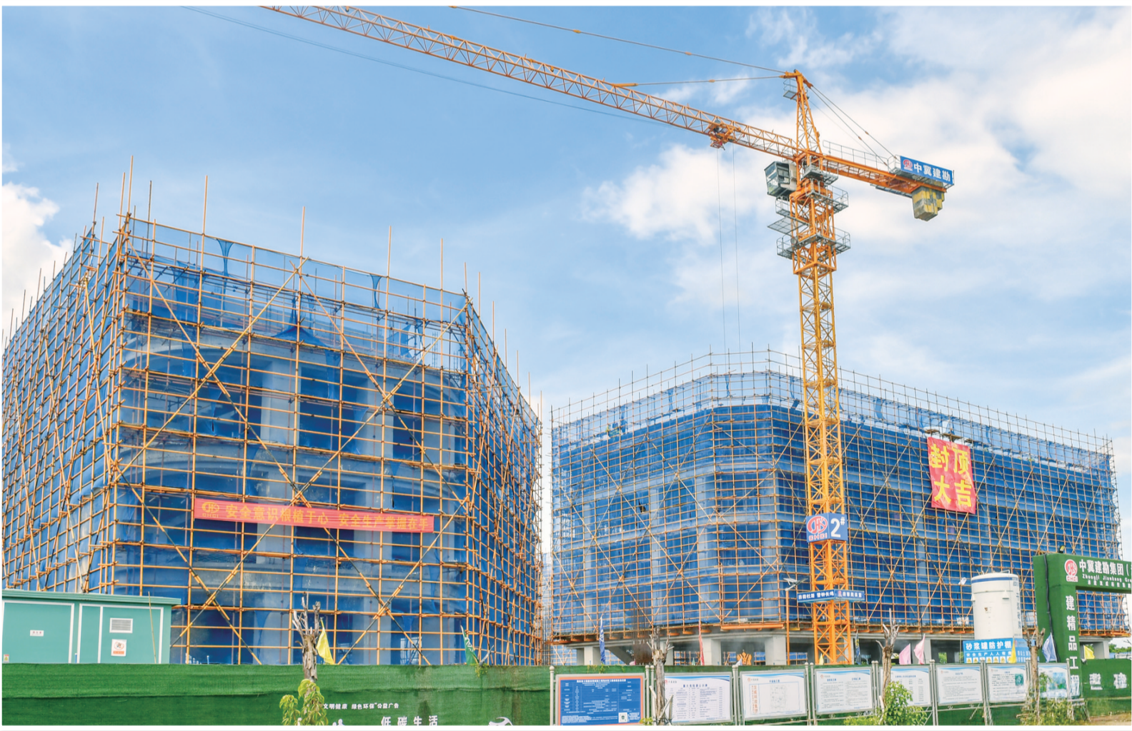
8月20日,位于海口江东新区的汉威科技集团海外业务中心项目主体结构全面封顶。
