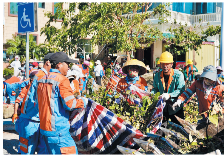
8月28日9时许，海口支援队在三亚天涯区海榆西线的清障作业进入最后攻坚阶段。本报特派记者 杨忠凯 摄
