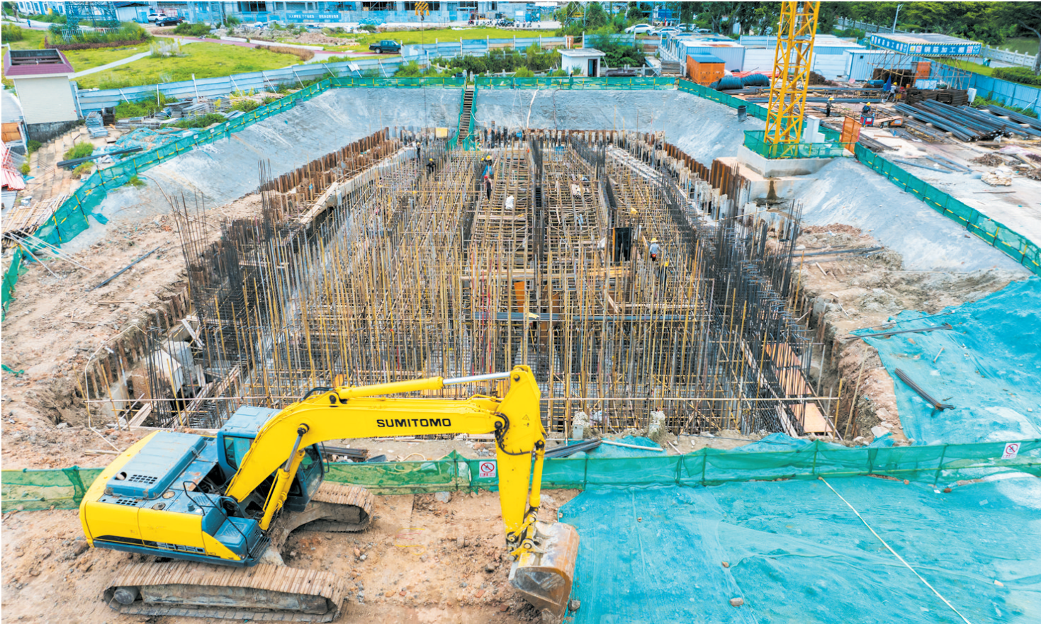
海甸岛鸭尾溪雨水排涝泵站项目建设现场一派繁忙景象。
