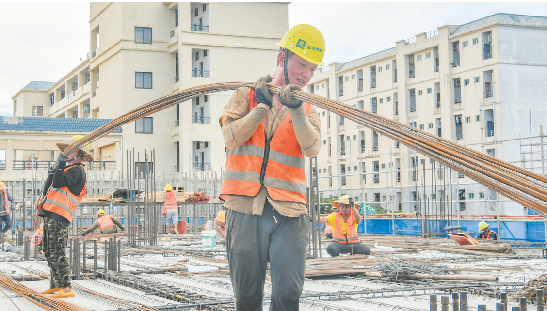
6月6日,在琼台师范学院桂林洋校区学生宿舍综合楼建设项目现场,施工人员在搬运钢筋。 本报记者 孙士杰 摄
