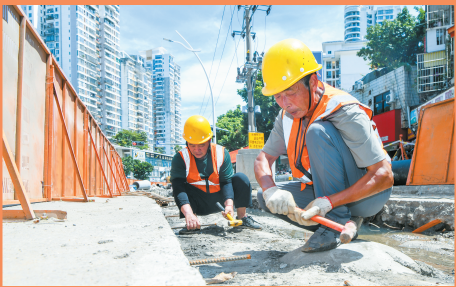
9月9日,在友谊阳光城积水点改造现场,施工人员正在新建雨水管道。 本报记者 苏弼坤 摄
