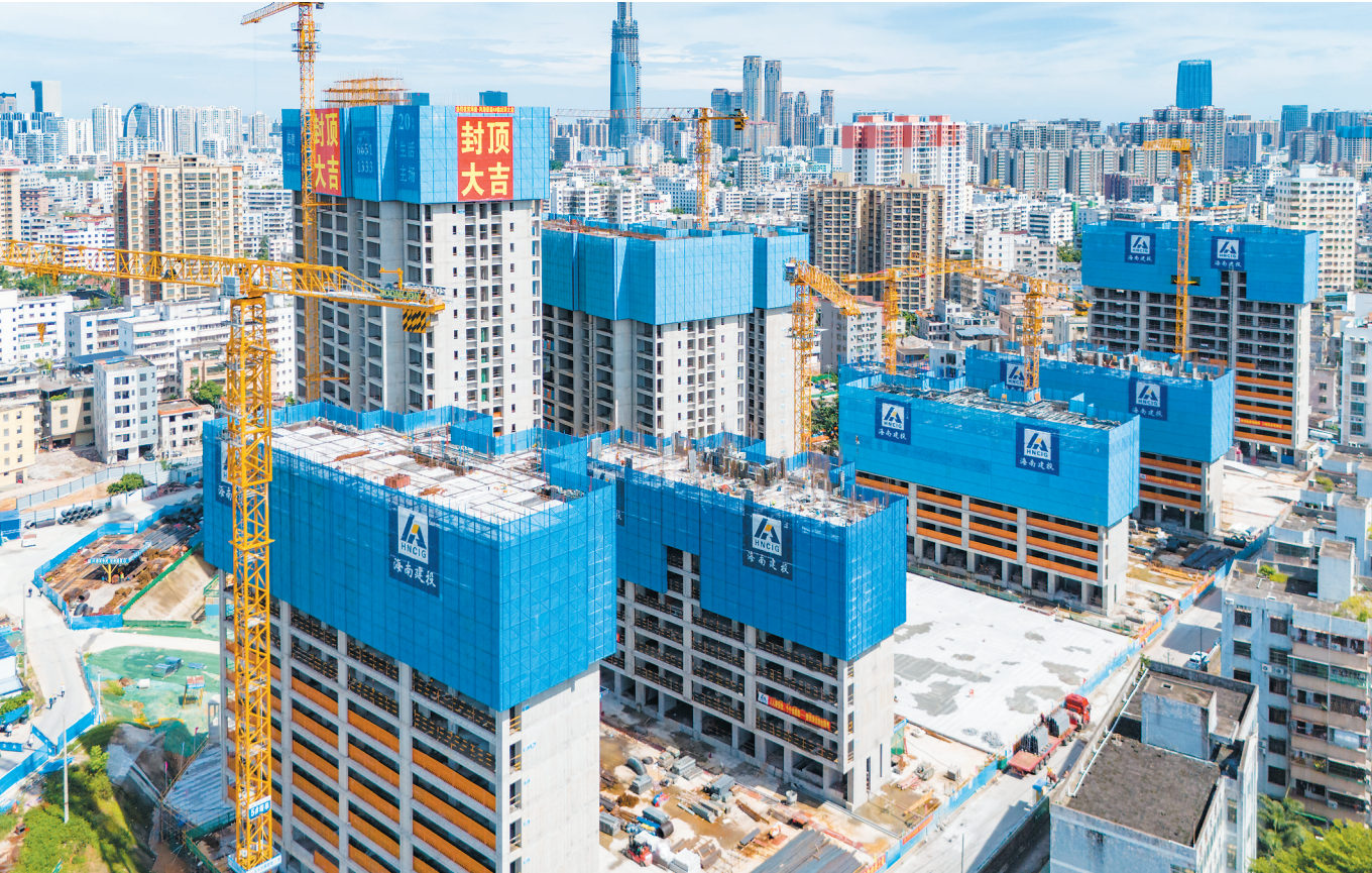
9月9日,航拍琼山区桂林片区(二期)城市更新项目现场。 本报记者 苏弼坤 摄
