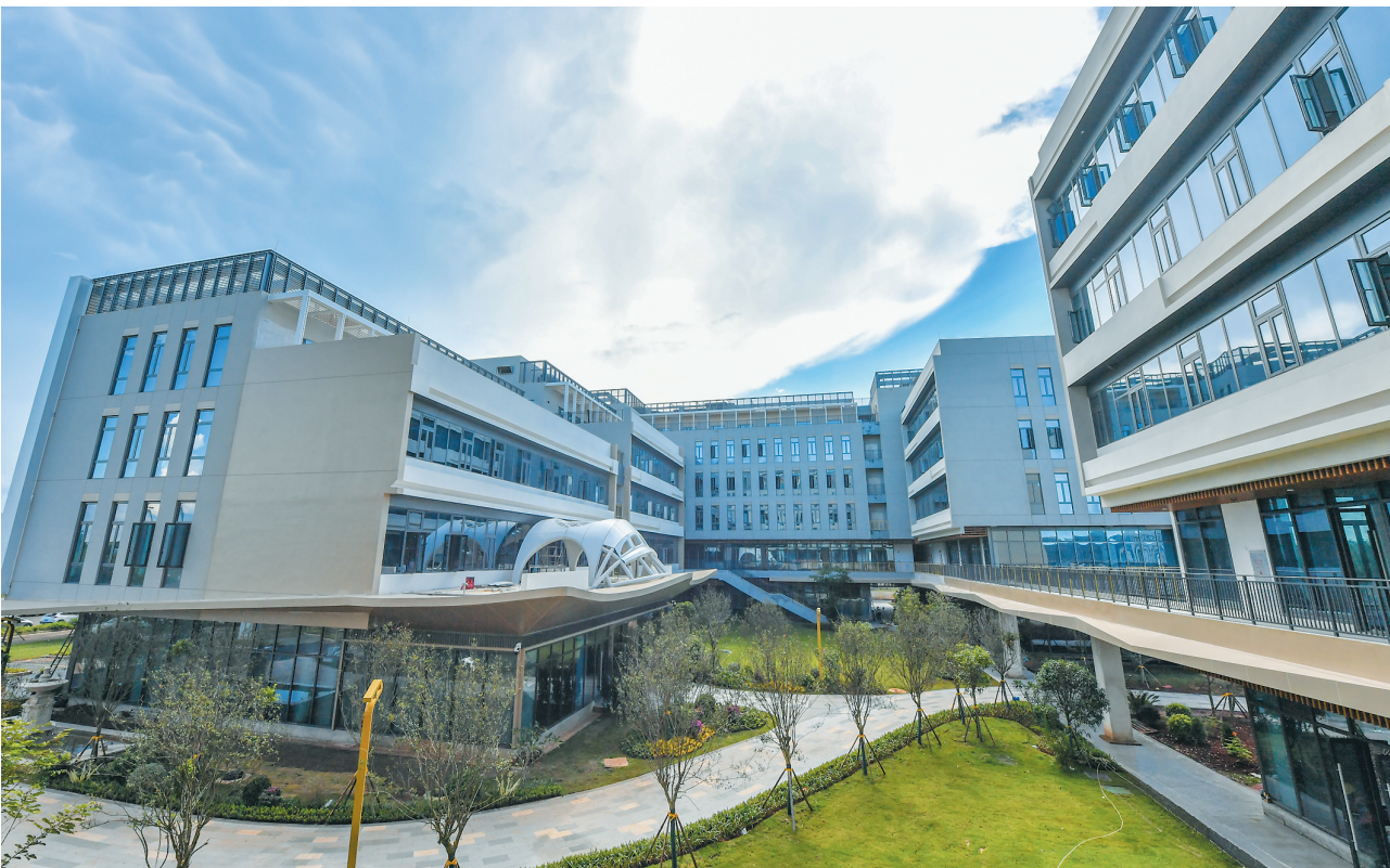
9月11日，在江东新区临空经济区，已经完工的航空科技研发基地项目正冲刺竣工验收。
