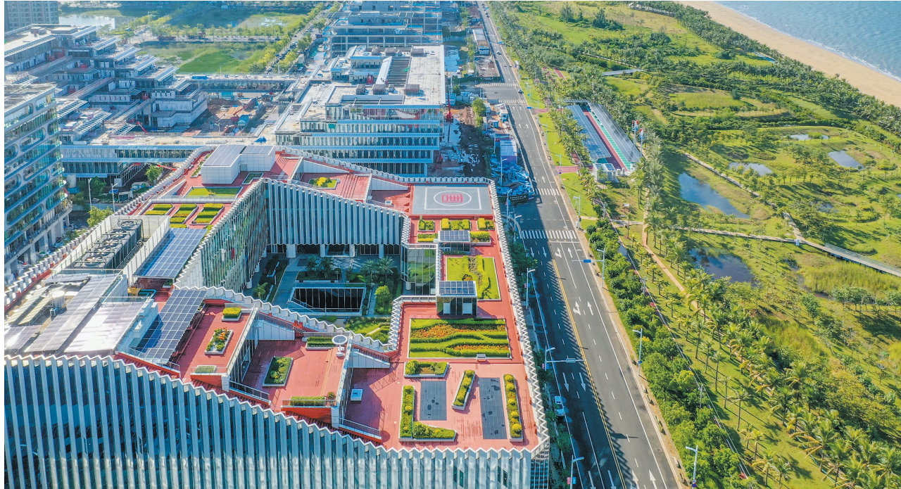
9月13日,俯瞰位于海口江东新区的大唐滨海源网荷储一体化智慧能源科创示范项目。 本报记者 孙士杰 摄
