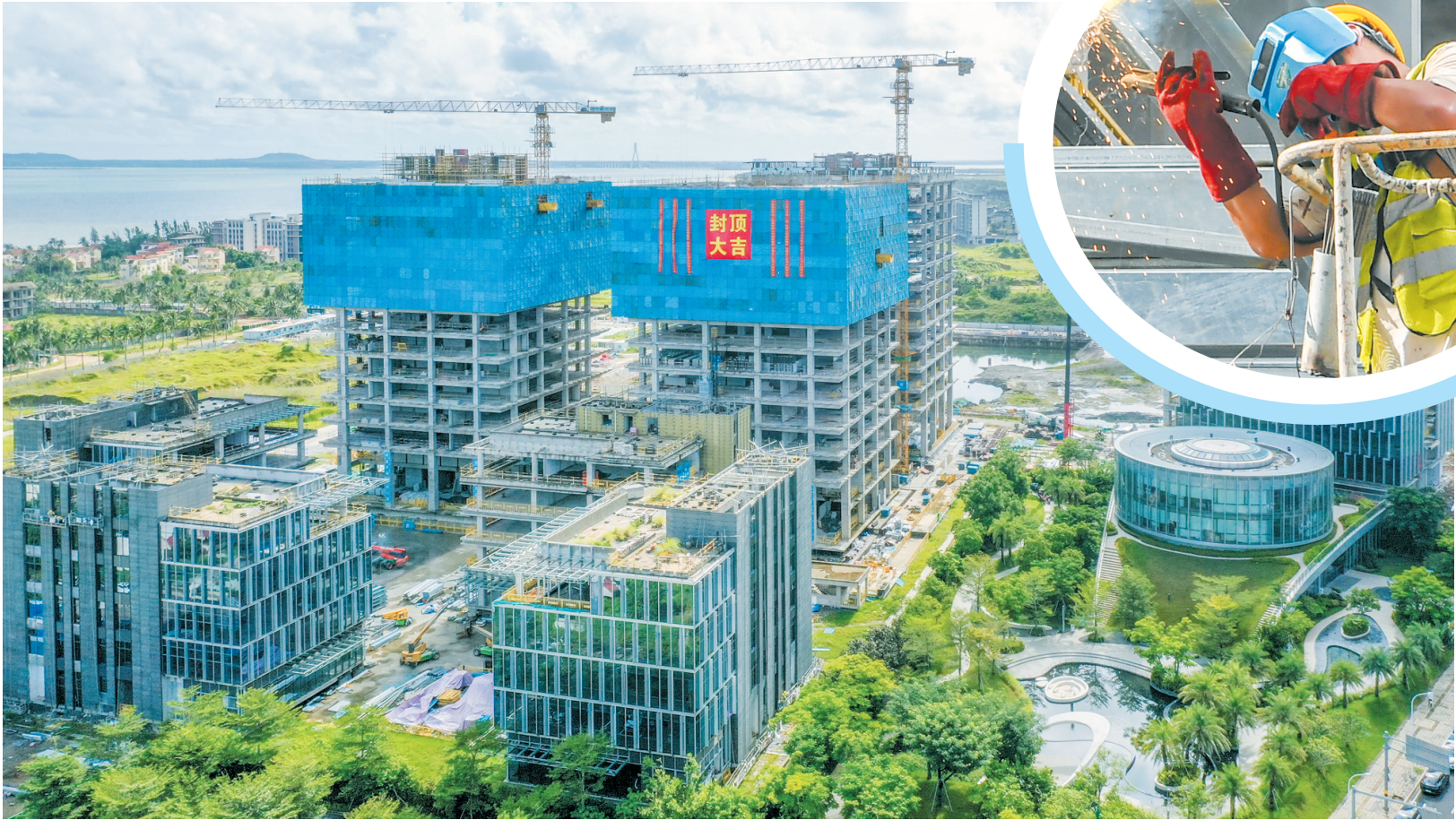
▲9月17日,位于海口江东新区的山东国际业务集聚区项目全面封顶。
