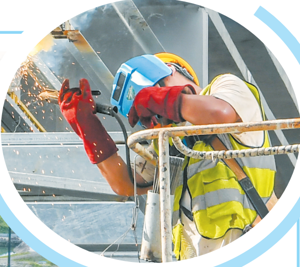
▲9月17日,在山东国际业务集聚区项目现场,施工人员在焊接外墙龙骨。本报记者 孙士杰 摄
