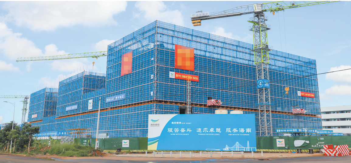
近日,海口江东新区高教科研组团的海南医科大学桂林洋新校区项目(二期)首栋单体建筑封顶。
