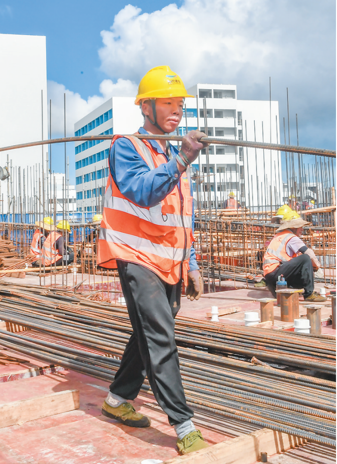
10月2日,在海南医科大学桂林洋新校区项目(二期)建设现场,施工人员在搬运钢筋。
