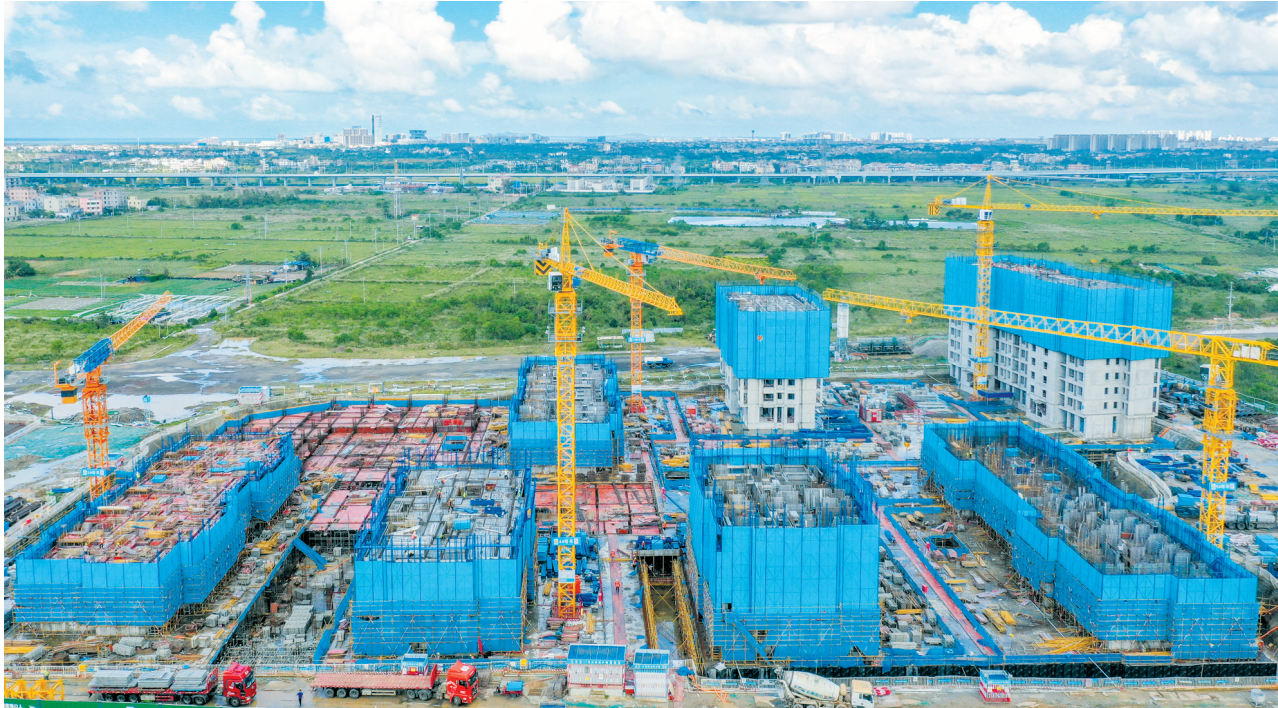
10月14日,俯瞰正在加快建设的江东新区兰香园回迁房项目。 本报记者 孙士杰 摄
