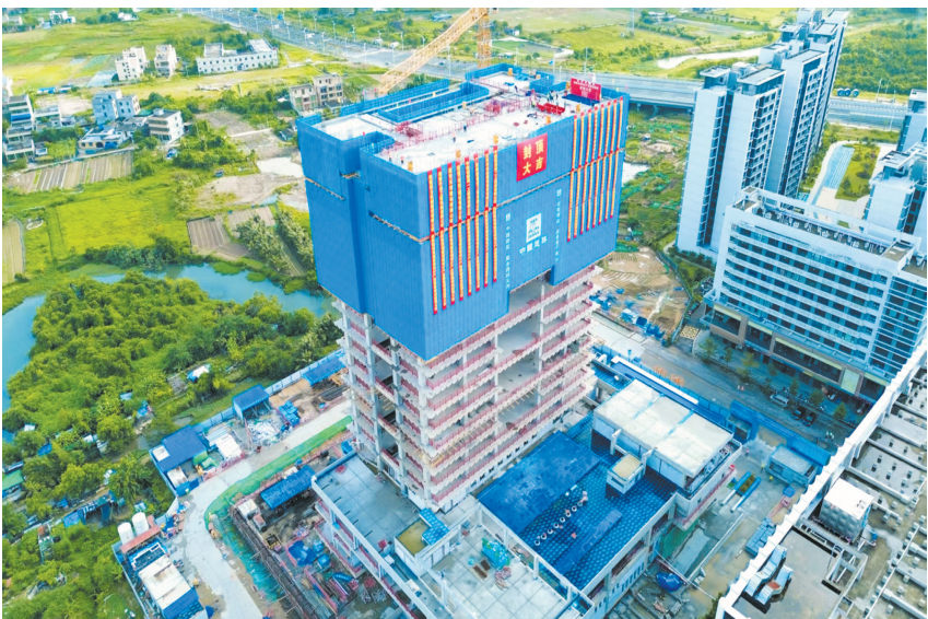
俯瞰已完成主体结构封顶的海南咨询设计产业基地项目。
