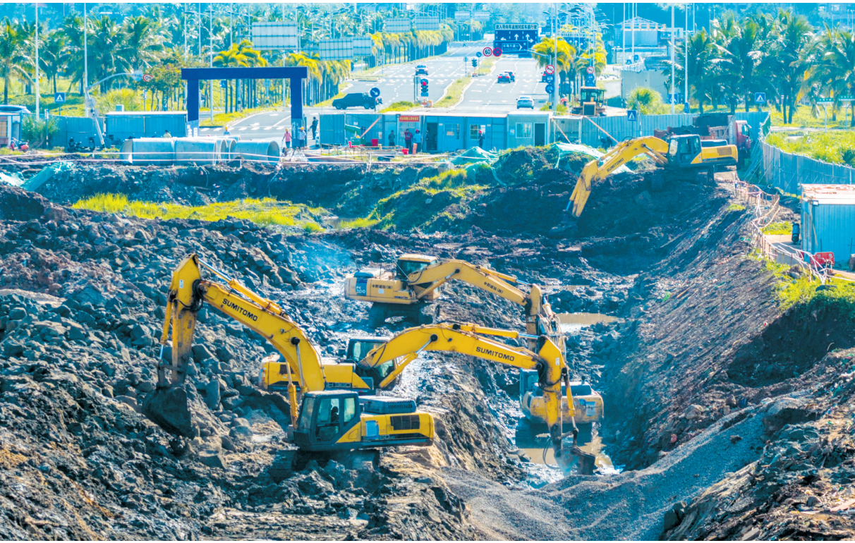
10月16日,在长流三号路项目(一阶段)施工现场,工人正在挖污水沟槽。
