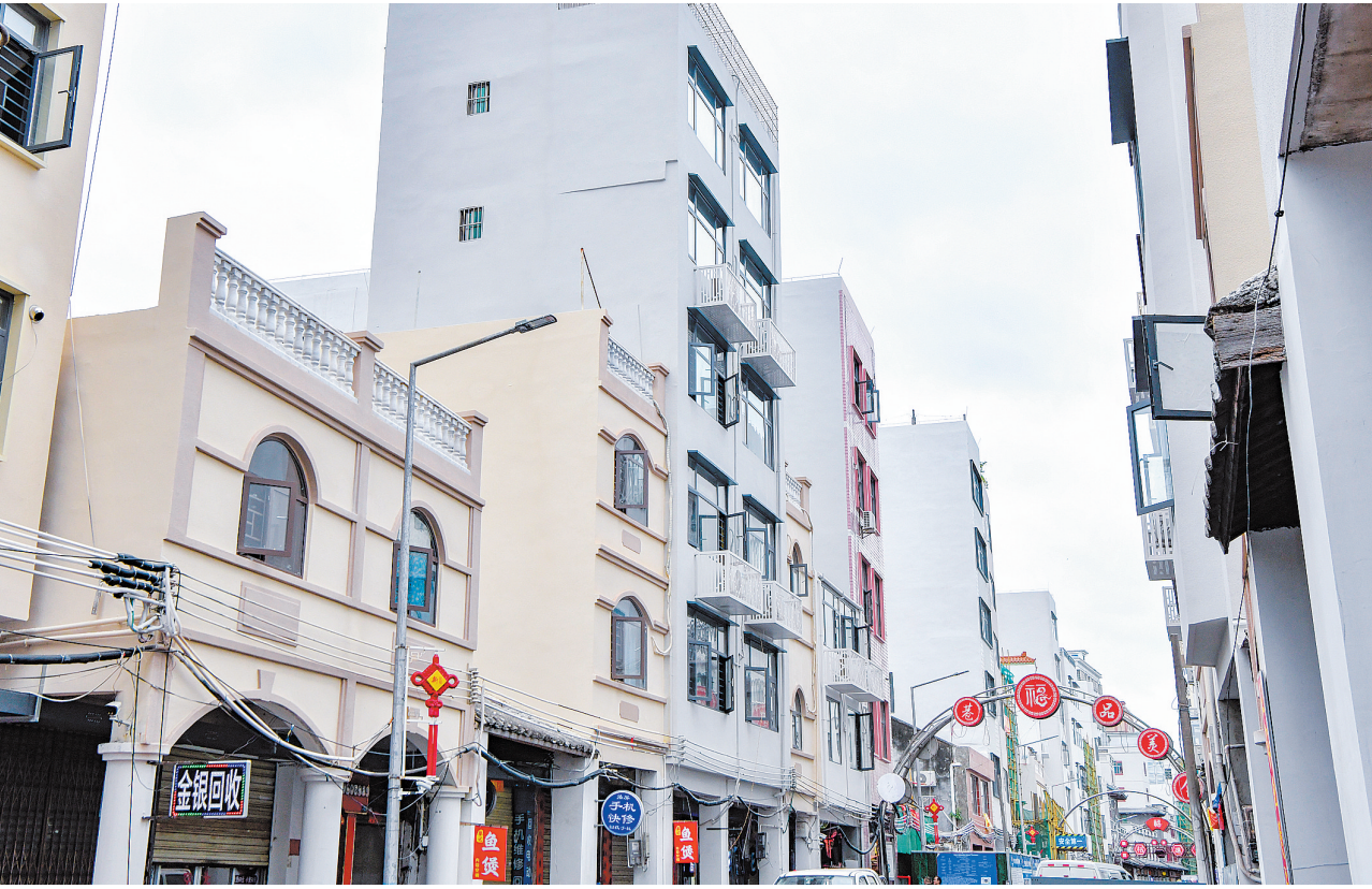
10月21日，在海口府城传统建筑历史文化街区保护提升项目现场，部分建筑外立面已经完成。 本报记者 苏弼坤 摄
