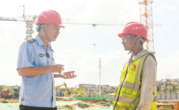
在施工现场,了解工人工资支付情况。
