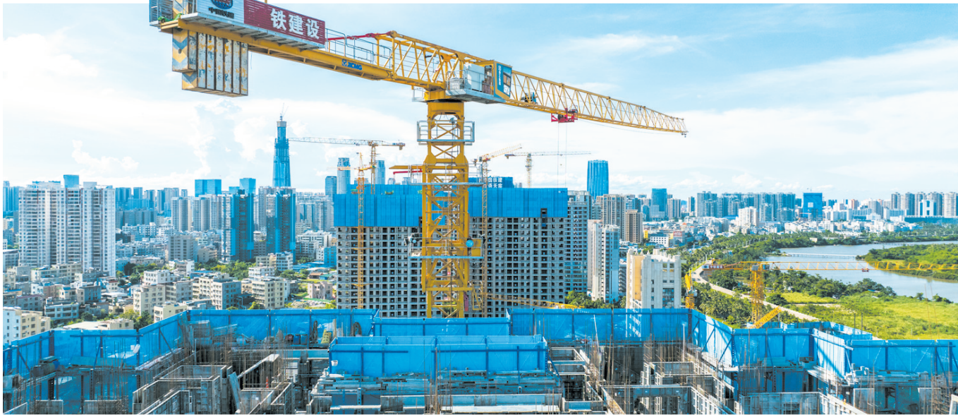
俯瞰正在加紧推进的博雅片区城市更新项目。 本报记者 杨鹤 摄
