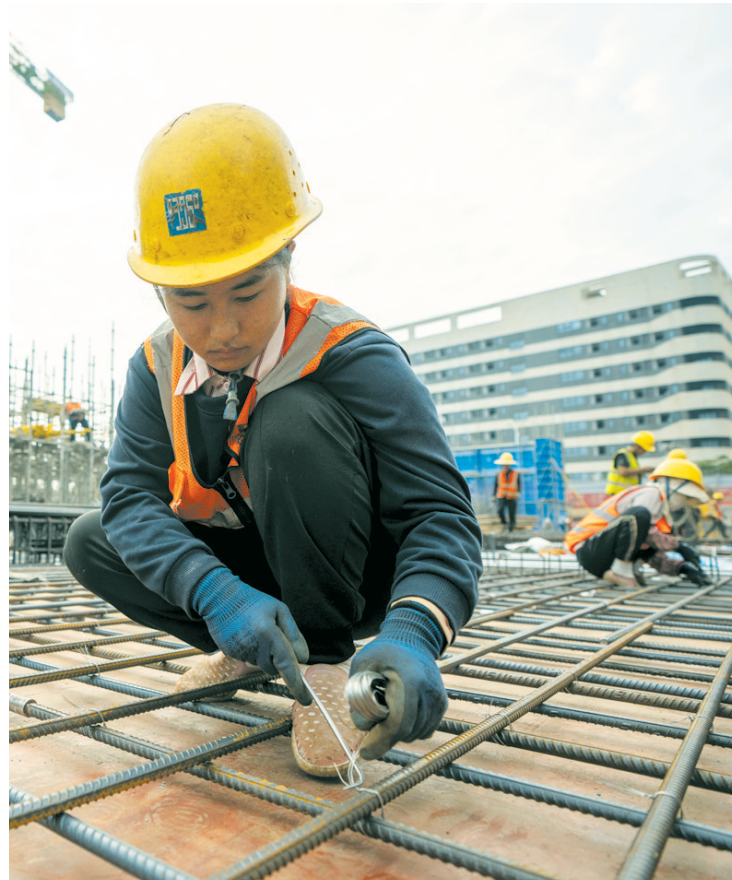
海南医科大学桂林洋新校区(二期)项目工作人员在绑扎钢筋，加快施工进度。
