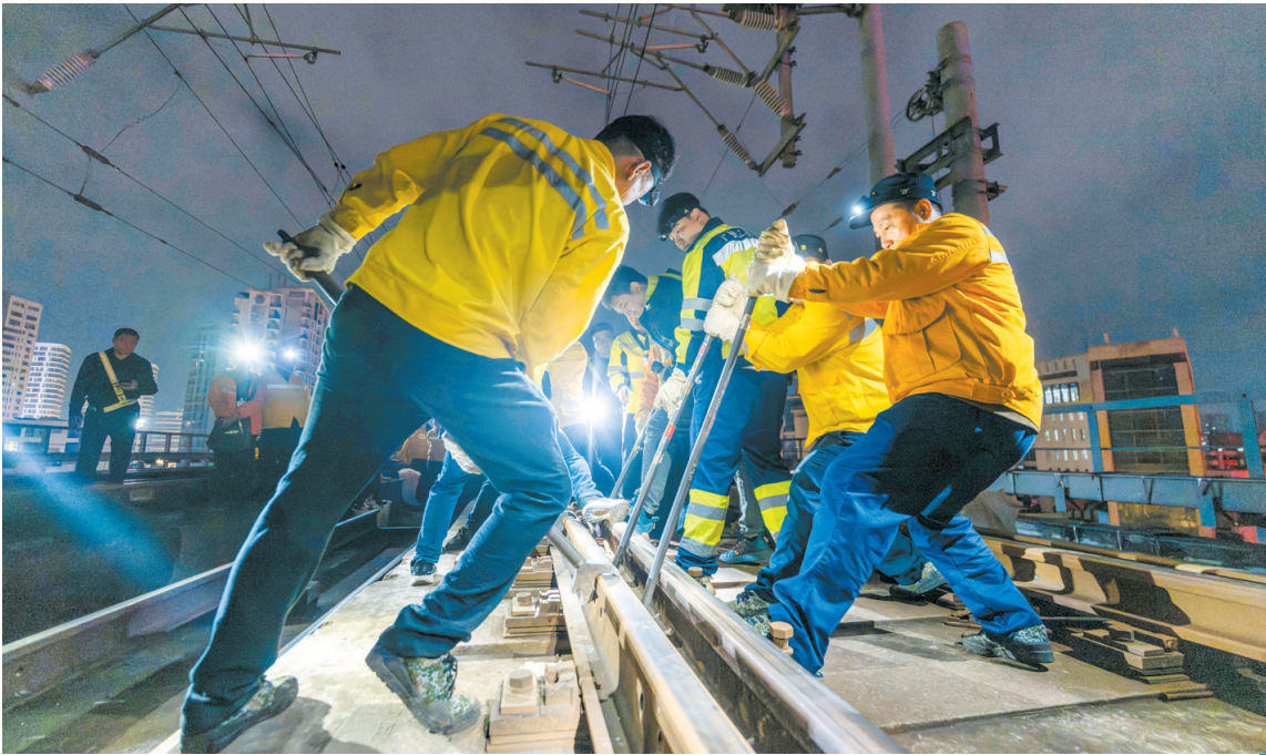
海口综合维修段在海南环岛高铁东段开展钢轨更换作业。 本报记者 苏涪坤 实习生 陈新锐 摄
