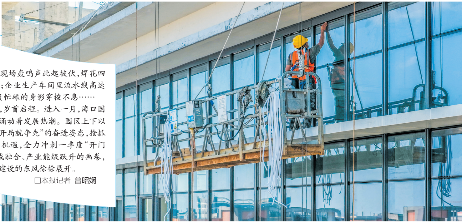
1月16日,在海口高新区生物医药产业创新中心项目现场,施工人员正在进行玻璃幕墙安装作业。 本报记者 康登淋 摄
