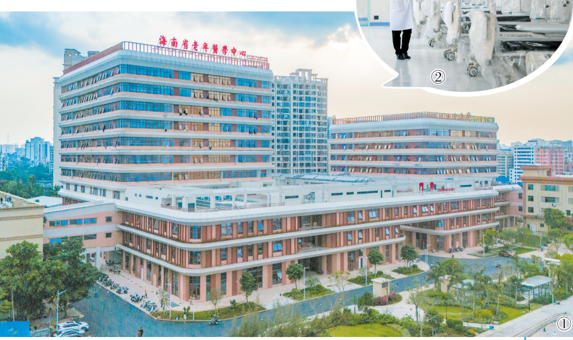
①已交付使用的海南省老年医疗中心(一期)。②3月31日,在海南省老年医疗中心(一期)ICU综合大厅内,医务人员正在检查医疗设备。本报记者 苏强坤 摄
