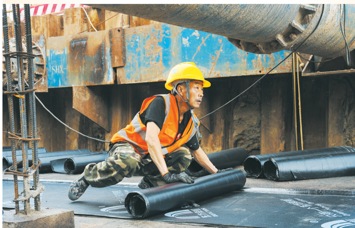
4月6日,海口江东新区海文南路市政化改造工程项目建设现场一派繁忙景象,建设者们加紧施工,全力推动项目自建提速增效。 本报记者 杨忠凯 摄
