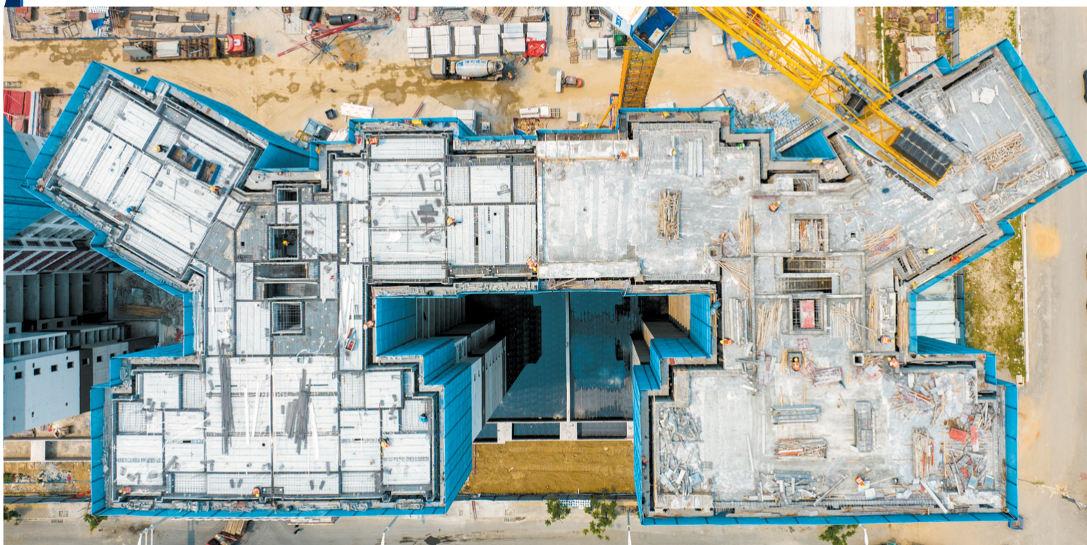
俯瞰位于海口江东新区综合服务组团的江东新区JDZH-04-F05地块项目,两栋住宅楼率先实现主体封顶。 本报记者 杨忠凯 摄
