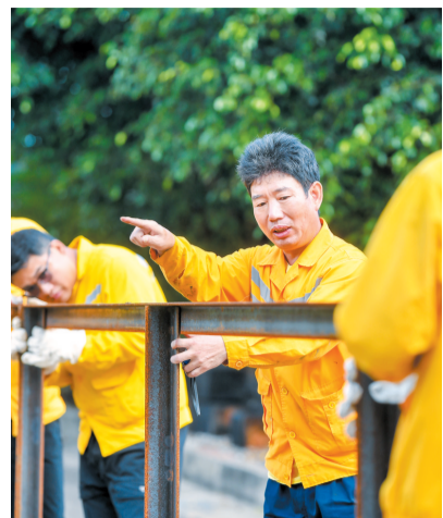
邓昌益(中)和同事一起加固工区梁杆。
