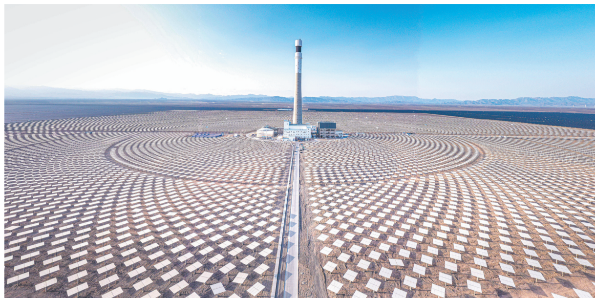
在新疆吐鲁番市鄯善县拍摄的1GW“光热+光伏”一体化项目(2025年7月28日摄,无人机照片)。新华社发
