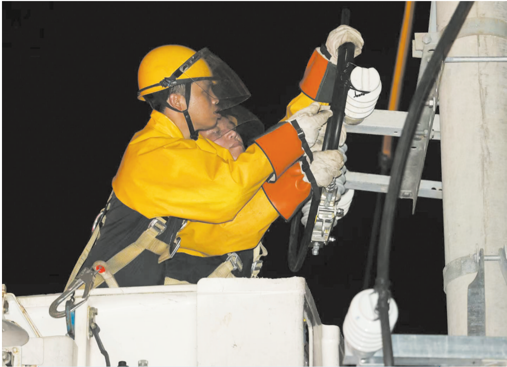
5月27日晚,海口供电局工作人员在振兴路抢修故障线路。
